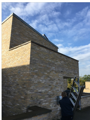
Ydervæg Skyttestien nr. 2 - Ingen tegn på opfugtning af murværk
