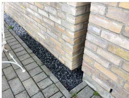
Voldgrav - Voldgrav fyldt med ekstra lag sten.
