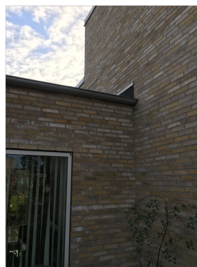
Ydervæg skyttestien nr. 60 - Ingen tegn på opfugning eller algevækst.
