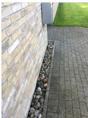
Voldgrav skyttestien nr. 99 - Voldgrav fyldt med ekstra lag sten.
